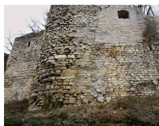
In der östlichen Ringmauer findet sich ein markanter Wechsel im Gefüge. Die kleineren Quader auf der rechten Seite könnten auf eine Reparatur nach dem Erdbeben von 1356 zurückgehen. Im oberen Bereich ist eine moderne Ergänzung.
